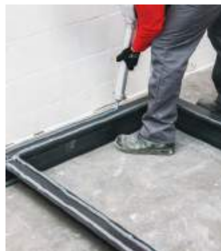
08 Applicare l'adesivo lungo tutto il perimetro del telaio, in 2 cordoli
