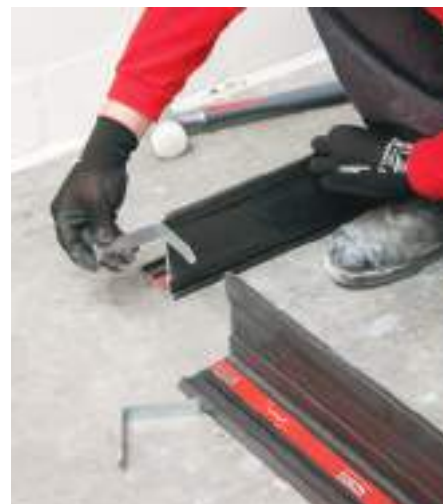
03 Inserire gli angoli di connessione
