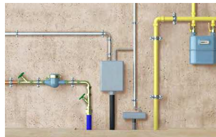
Fissaggio delle condotte.
