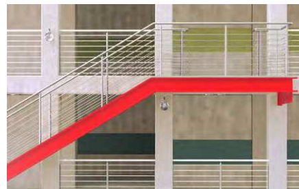
Strutture in acciaio.
