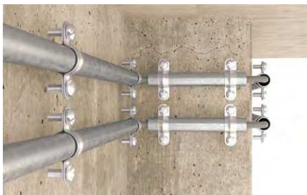
Fissaggio delle condotte in acciaio.
