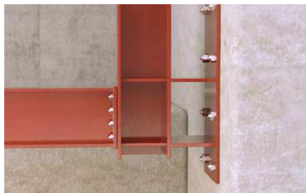
Strutture in acciaio.
