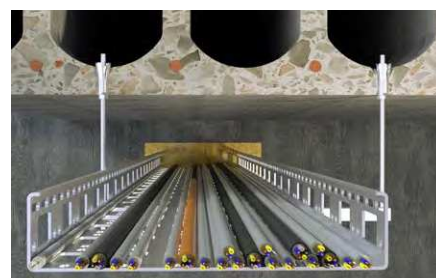
Solai in calcestruzzo alveolare precompresso.
