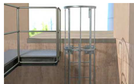
Scale di manutenzione.
