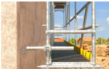
Fissaggio al ponteggio.
