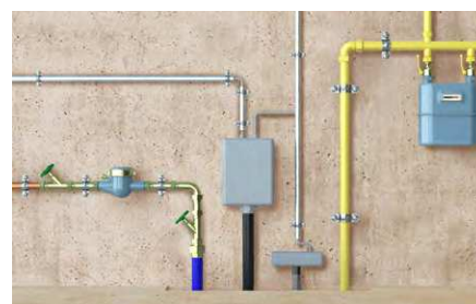
Fissaggio di tubazioni a parete e a soffitto.
