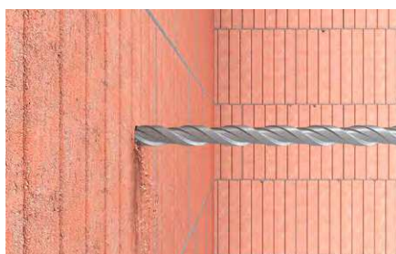
Foratura in mattoni forati
