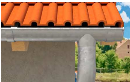
Posizionamento di tegole e coppi.
