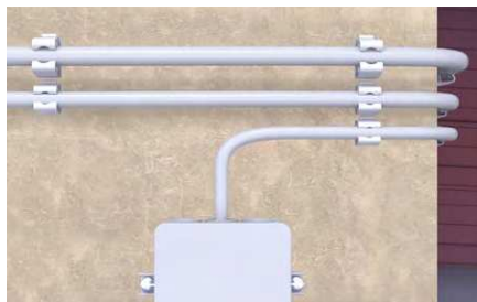
Fissaggio tubi in PVC.
