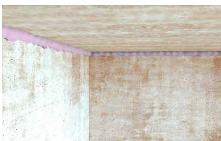
Giunti di chiusura in opere strutturali.
