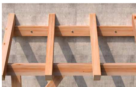
Strutture in legno.
