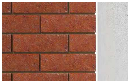
Giunti in muratura.
