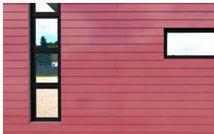
Sigillatura di serramenti.
