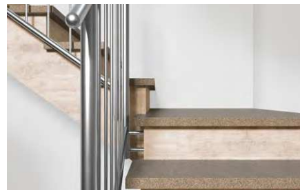
Pedate di gradini su traverse di scale in calcestruzzo.
