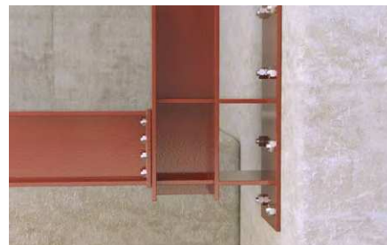
Travature in acciaio.
