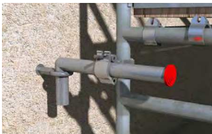
Fissaggio al ponteggio.
