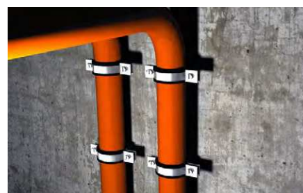
Fissaggio di condotte in plastica.
