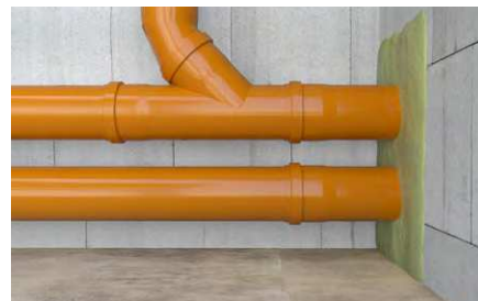
Riempimento di attraversamenti di tubazioni.
