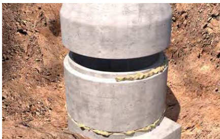
Sigillatura anelli di pozzetti di calcestruzzo.
