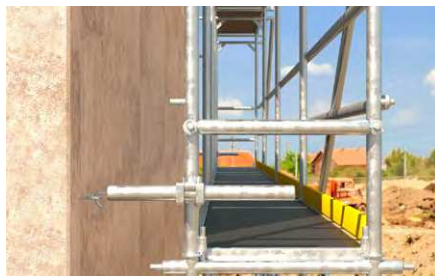
Fissaggio al ponteggio.
