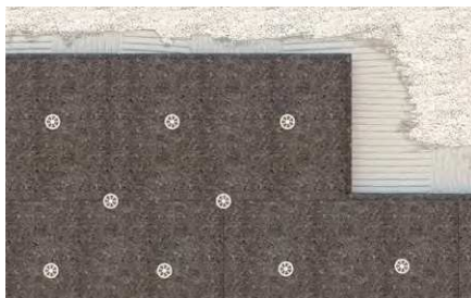
Fissaggio di pannelli isolanti.
