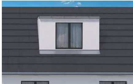
Fissaggio di lattonerie.
