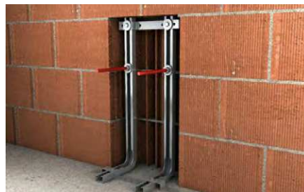
Dettaglio: installazione sistema L Plus.
