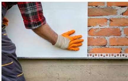
Incollaggio di lastre di cartongesso.
