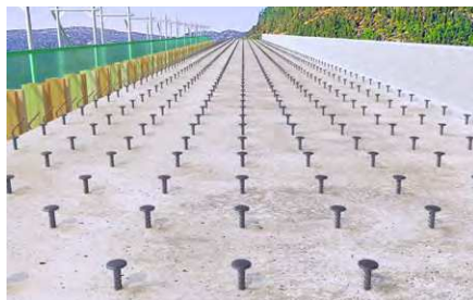
Rinforzo di solette da ponte.
