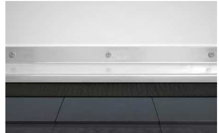
Fissaggio di scossaline in lamiera.
