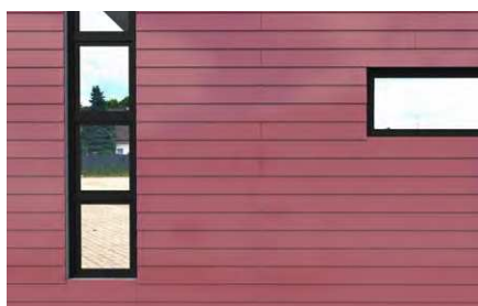
Sigillatura di serramenti.
