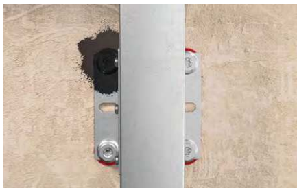
Sigillatura della testa delle viti.
