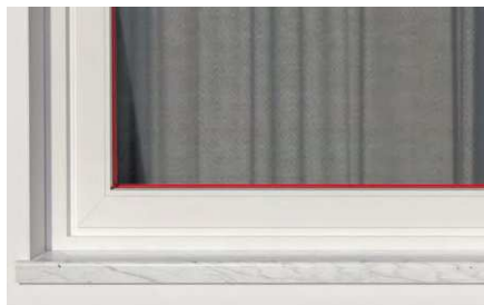
Sigillatura interna ed esterna di serramenti.
