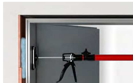
Schiumatura di telai di porte.
