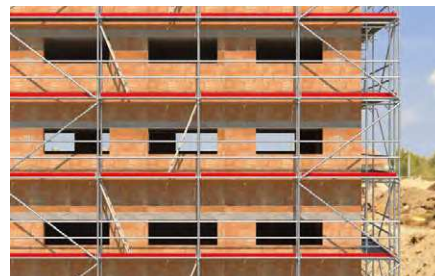
Ponteggi di facciata.
