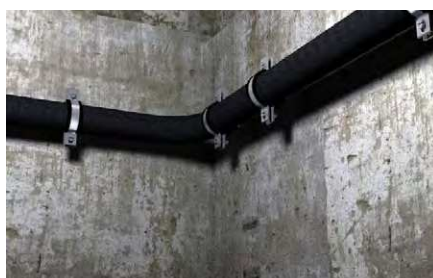
Fissaggio di condotte in metallo.
