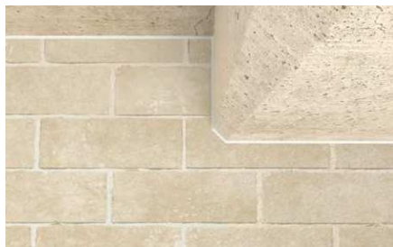
Giunti di costruzione.
