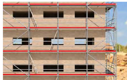
Ponteggio per facciata.
