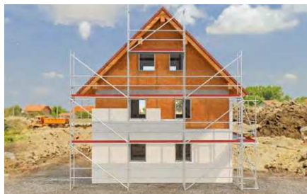
Incollaggio di pannelli isolanti per sistemi ETICS.
