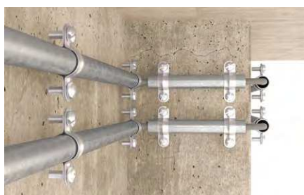
Fissaggio delle condotte in acciaio.
