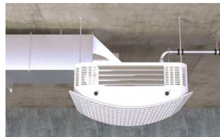
Sigillatura di condotti di ventilazione.
