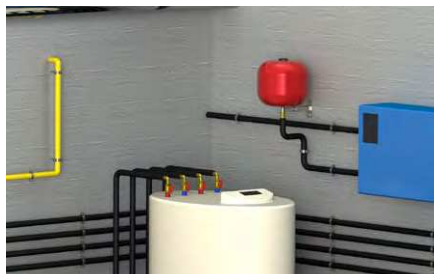
Sostegno di vasi d'espansione.
