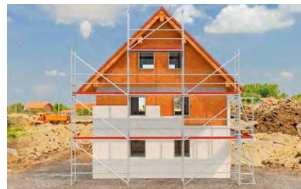
Fissaggio di pannelli di isolamento a cappotto.
