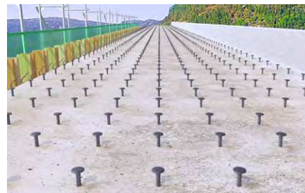
Connettore a taglio per il rinforzo di solai.
