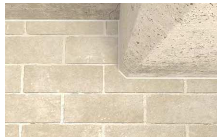
Giunti lineari fra parete e solaio.
