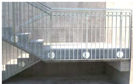
Carpenteria in acciaio.
