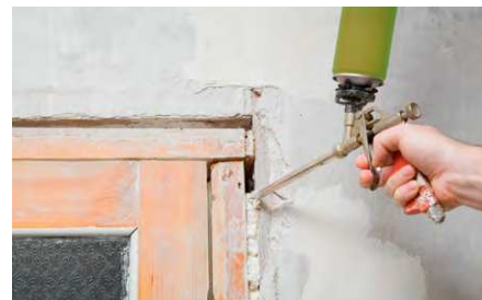
Posizionamento rapido di controltelai.
