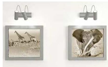
Installazione di plafoniere in serie.
