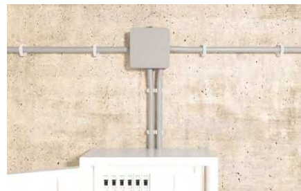
Fissaggio tubi in PVC.
