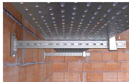
Staffaggio di impianti elettrici.
