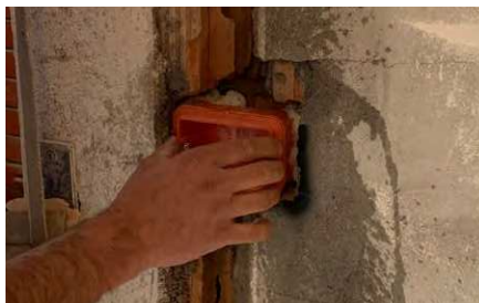
Pre-fissaggio di scatole elettriche.
