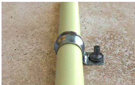
Fissaggio di tubi rinforzati.
