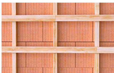
Sottostrutture in legno.
