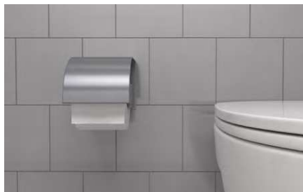
Incollare accessori bagno.
