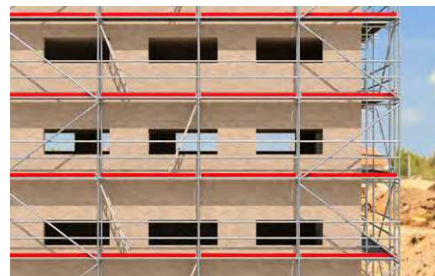
Ponteggio per facciata.
