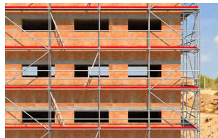
Ponteggio per facciata.
